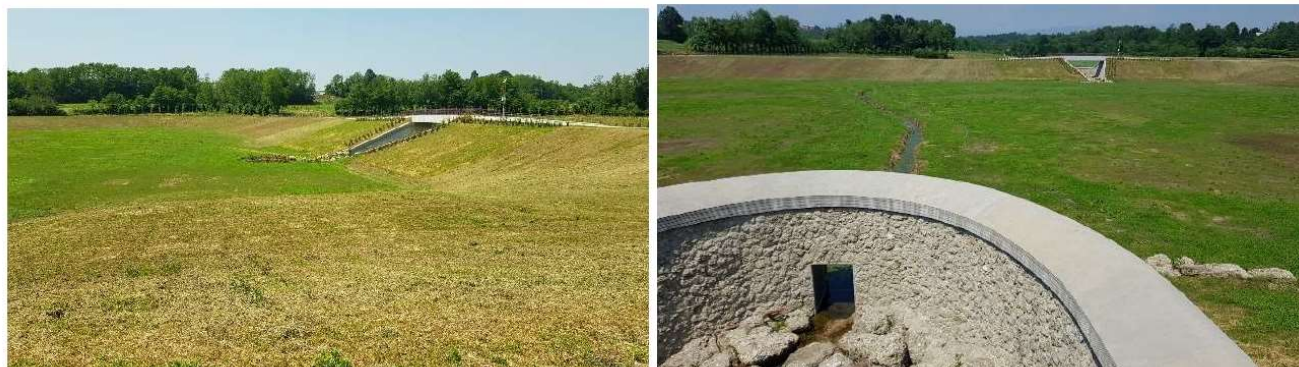
Figura 14 - Manufatto di restituzione (vista da valle e vista soglia di sfioro con luce di scarico)
