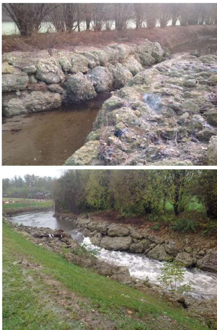
Figura 12 - Restringimento in massi torrente Lura a Lomazzo
