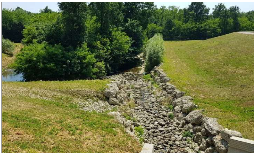
Figura 29 - nuovo tratto di alveo similare realizzato sul torrente Lura a valle del manufatto di regolazione
